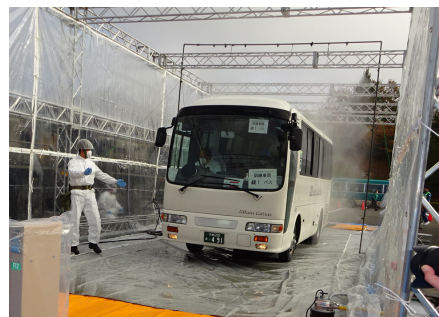
「足場」に設置したシャワーによる除染
