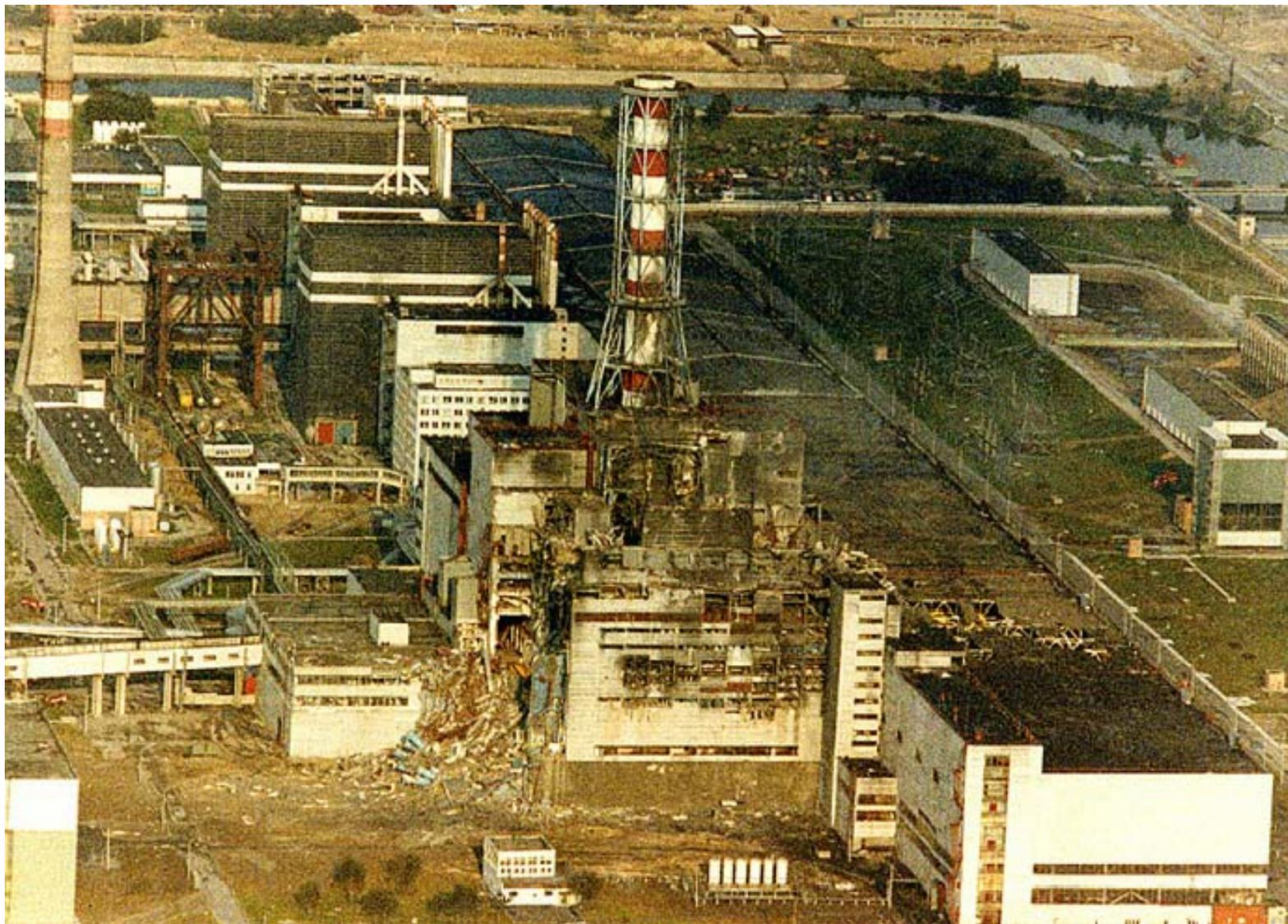
爆発したチェルノブイリ4号炉（手前の破壊された部分。煙突の向こう側は3号炉）
